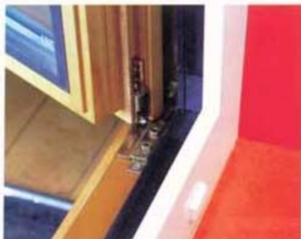
Situación interior del herraje OB oculto del sistema de aluminio/madera Contur 21
