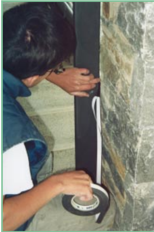
Para el sellado de estanqueidad se ha utilizado la cinta expansiva Illmod 600
