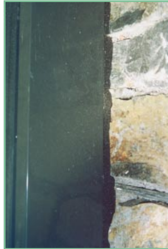
Para el sellado de estanqueidad se ha utilizado la cinta expansiva Illmod 600
